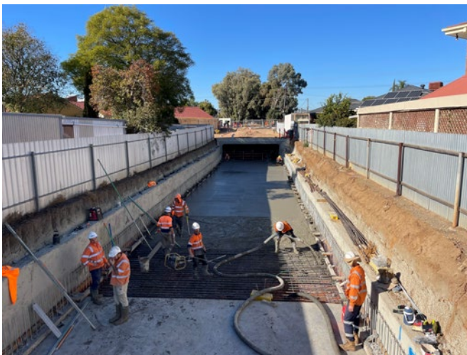
Final concrete pour for new channel base
